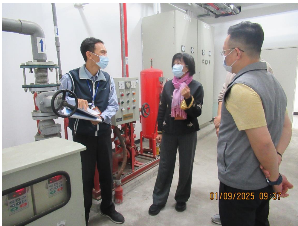
圖二、雲林監獄秘書會同政風室、業管單位檢查消防設備
